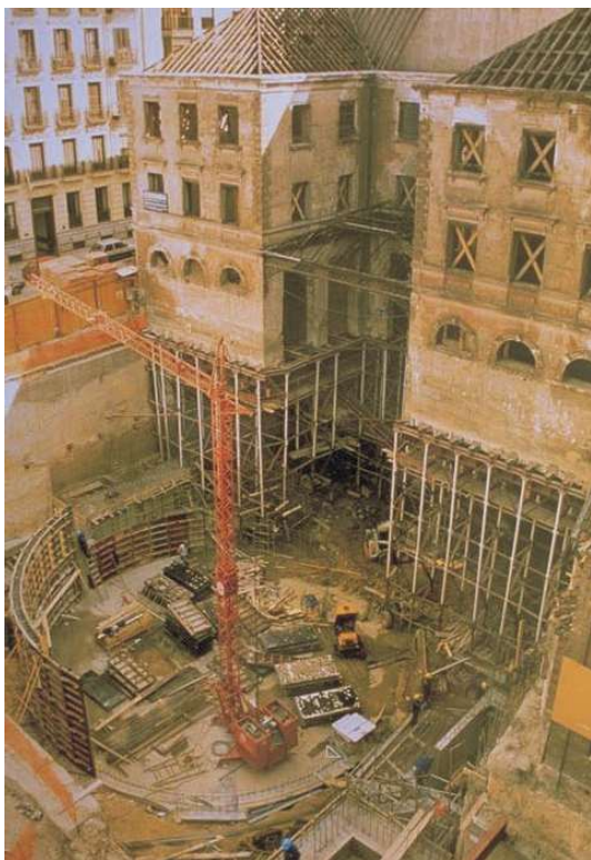
PROCESO DE OBRA. EJECUCIÓN DE LA AMPLIACIÓN SUBTERRÁNEA
