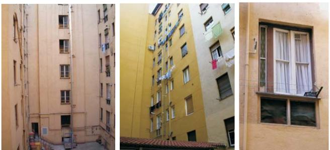
Fotos de alteraciones en elementos de los patios, especialmente las ventanas. Es patente el mal estado de conservación, la aparición de elementos extraños y la falta de uniformidad en las soluciones adoptadas. Fotografía: MMN Arquitectos. Octubre 2003.
