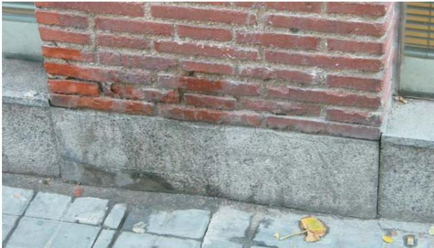
Foto 2'- Zócalos a pie de arcos recubiertos con chapados de piedra.
