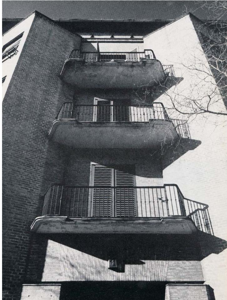
Arriba: Detalles de bandejas en la el detalle actualmente existente. Obsérvese la menor delicadeza del detalle en comparación con el inicial que se observa en la foto de la derecha. Fotografías: MMN Arquitectos, Oct. 2003
