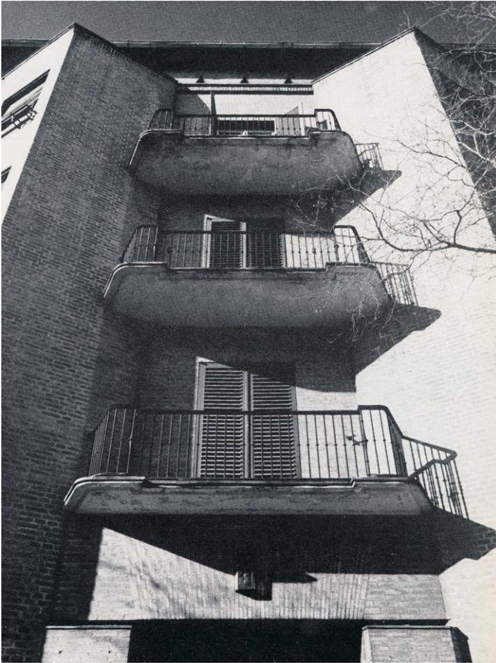
Fotografía de Catalá Roca sin datar reproducida en *Quaderns* núm.150, 1982, pág.86. Las bandejas, aún con el espesor original, conservaban la ligereza que contrastaba con los masivos cuerpos de ladrillo laterales.
