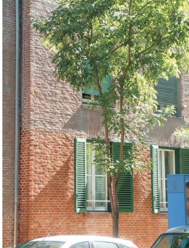
Fachada a calle Hilarion Eslava (núm.2). Obsérvese la vibración de la fachada ante la luz rasante y la diferencia de color en las partes que se han limpiado. MMN Arquitectos. Nov. 2003.
