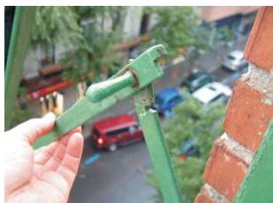
El sistema es de fácil manejo. Las fotografías muestran con más detalle el aspecto de los herrajes originales: A la izquierda aparecen el brazo extensible compuesto por dos pletinas y su conexión con la guía móvil; mientras que a la derecha se muestra el sistema de fijación en posición cerrada y la bisagra de unión de la parte fija y la móvil de las guías.
