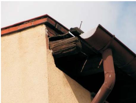
Hilarión Eslava, 2. Los elementos de madera de las cubiertas expuestos a la intemperie se encuentran en muy mal estado de conservación, por falta de mantenimiento, sólo posible por su difícil acceso mediante andamiaje.
