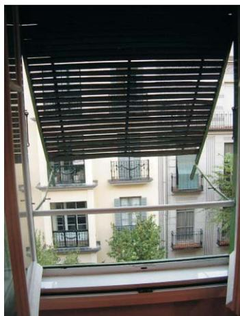
Como si se tratase de un toldo, incluso con mayor calidad aislante, el sistema asegura unas buenas condiciones térmicas para verano en latitudes como la de Madrid, puesto que crea un "colchón" de aire entre la protección solar y el interior de la vivienda, conservando las condiciones de luminosidad y vistas que aportan las ventanas, de grandes dimensiones.
