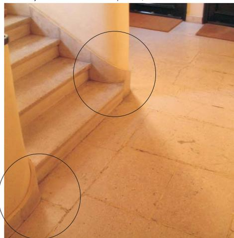
Se puede observar el magnífico detalle en la transformación del rodapié a zanquin mediante una pieza intermedia curva. Meléndez Valdés 59. MMN Arquitectos, Oct-2003.
