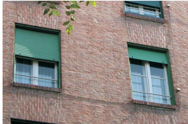
*Ventana en Hilarión Eslava, 2. Aquí se han incorporado dobles ventanas al interior manteniendo la ventana original al exterior. Como se puede apreciar, conservando un despiece razonable al interior la solución es bastante respetuosa con la imagen del edificio.*
