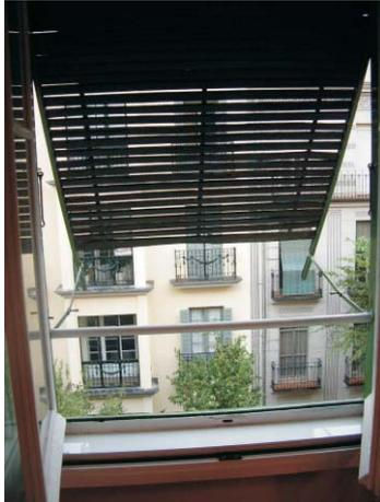
Como si se tratase de un toldo, incluso con mayor calidad aislante, el sistema asegura unas buenas condiciones térmicas para verano en latitudes como la de Madrid, puesto que crea un "colchón" de aire entre la protección solar y el interior de la vivienda, conservando las condiciones de luminosidad y vistas que aportan las ventanas, de grandes dimensiones.
