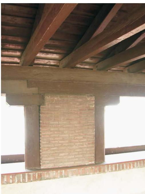
Conexión de la estructura de madera a la de fábrica
