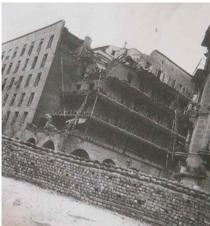
Recorte de periódico sin localizar y sin datar proporcionado por la vecina Dña. Gloria Grande Mingo. El edificio aparece destrozado en esta esquina, que en 1942 aún estaba en obras de restauración.
