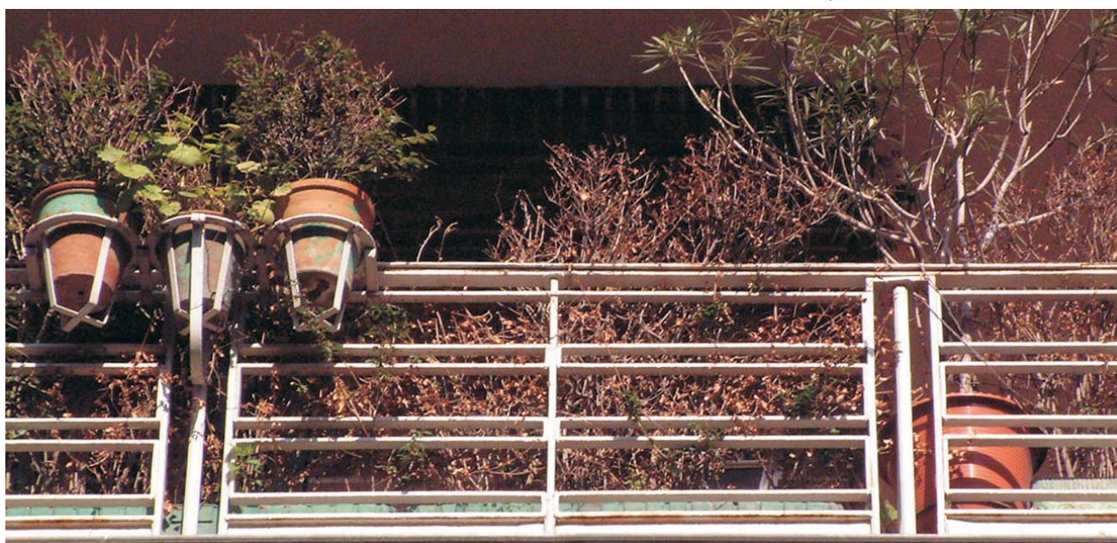
Detalle de macetero en Rodríguez San Pedro, 70. MMN Arquitectos, Nov-2003
