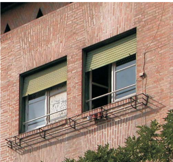
Grupo de ventanas en Gaztambide 19. Éste es el modelo de jardinera que se coloca bajo las ventanas de los cuerpos centrales a las calles Hilarion Eslava y Gaztambide. MMN Arquitectos, Oct-2003
