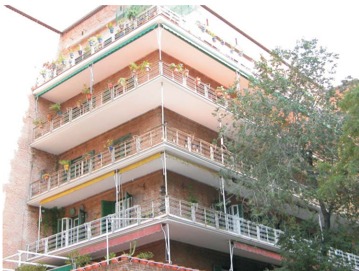
Barandillas en terraza de Rodríguez San Pedro, 72. Este modelo se repite en todas las terrazas de las dos esquinas de Rodríguez San Pedro. MMN Arquitectos, Oct-2003
