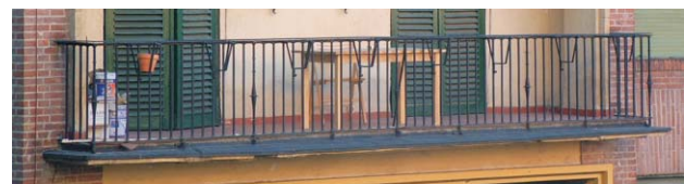
Detalle de maceteros en Rodríguez San Pedro 70. MMN Arquitectos, Sept-2003
