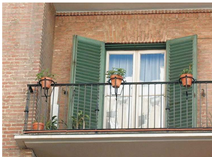
Meléndez Valdés 61. Contraventanas en ventanas balconeras.
