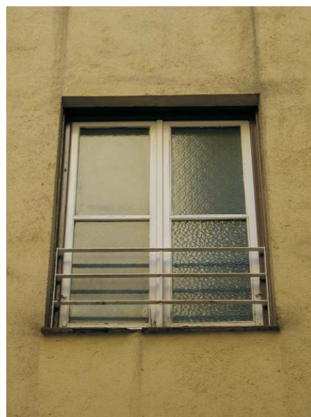
Ventana escalera en Rodríguez San Pedro, 70. MMN Arquitectos, Nov. 2003
