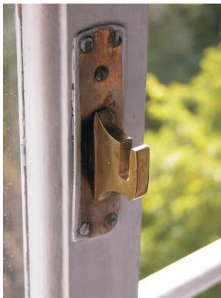
Herrajes de ventana de Rodríguez San Pedro, 72. Fotografía MMN Arquitectos, Sep. 2003.
