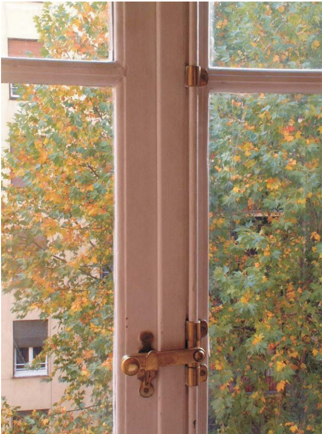
Herrajes de ventana de Hilarión Eslava, 6. Fotografía MMN Arquitectos, Sep. 2003.
