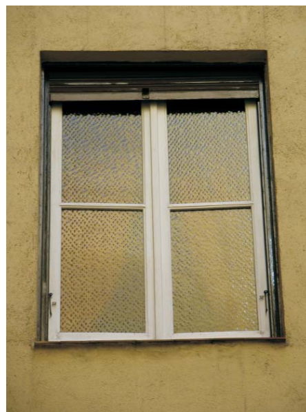
En las fotos superiores, ventana a jardín a patios interiores. La de la protección metálica es de la zona de escaleras.
