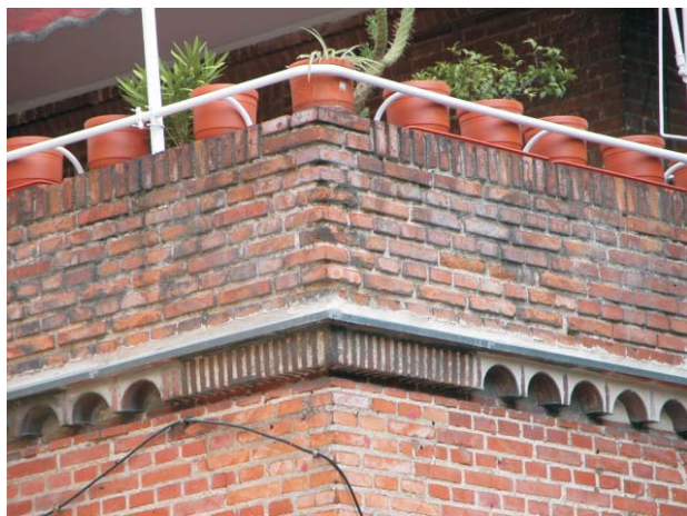
Detalle de fachada de ladrillo en Rodríguez San Pedro, 72. MMN Arquitectos. 15-10-2003.
