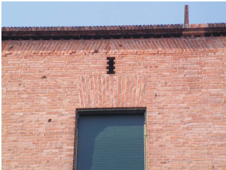
Detalle cornisa en Gaztambide 17. MMN Arquitectos, Nov. 2003
