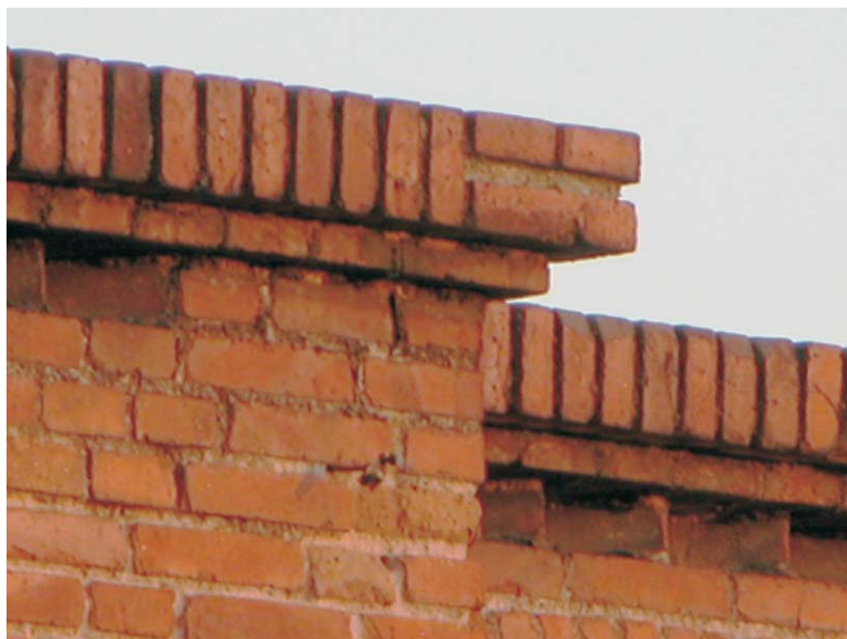
Detalle cornisa en Rodríguez San Pedro, 70. MMN Arquitectos, Nov. 2003
