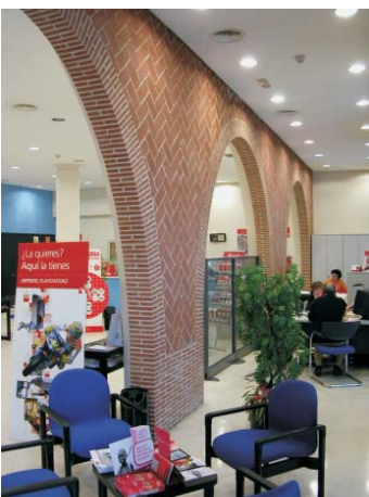
Fotos 3 y 4- Reposición de arcos de la fachada interior en la oficina bancaria existente en la actualidad. Fotografías: MMN Arquitectos. Octubre 2003.
