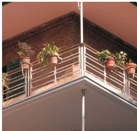
Detalle de esquina de Hilarión Eslava y Rodríguez San Pedro (RP-72). Se puede observar el fino soporte. MMN Arquitectos, Oct. 2003
