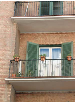
Terraza de Meléndez Valdés, 61, hacia la vía pública.
