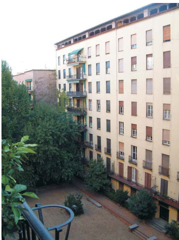
Foto 1'- Alzado interior a patio. Corresponde a la fachada de los portales Gaztambide n°17 y n°19 MMN Arquitectos, Octubre 2003
