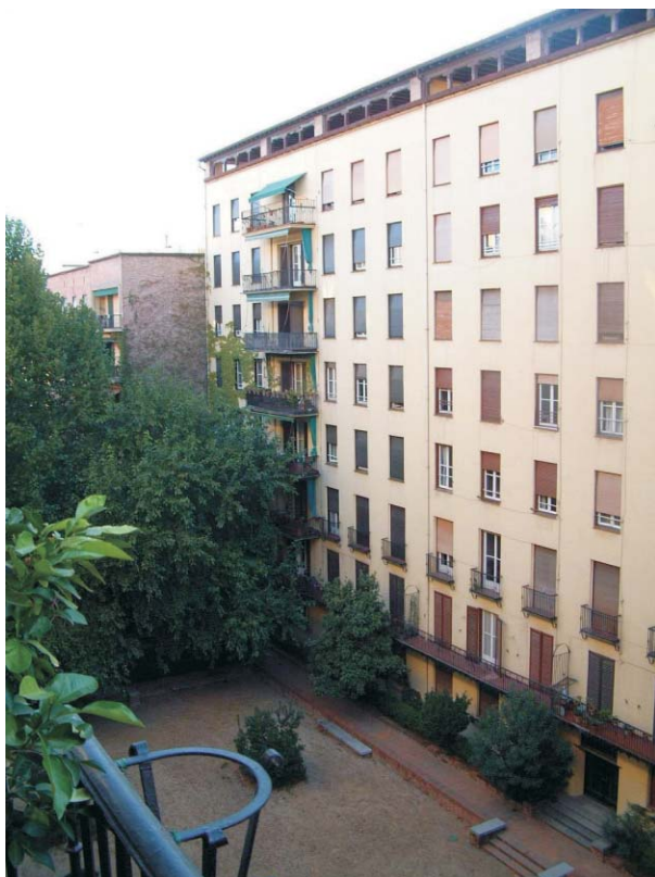
Foto 1'- Alzado interior a patio. Corresponde a la fachada de los portales Gaztambide n°17 y n°19 MNM Arquitectos, Octubre 2003
