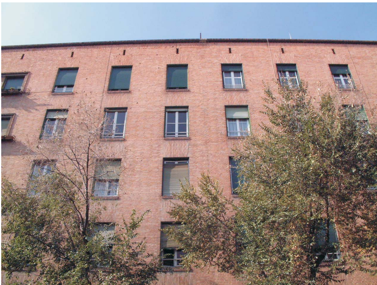
Fachada en Gaztambide 17. MMN Arquitectos, Nov.2003
