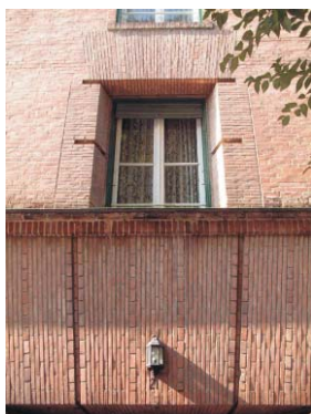
Fachada en Gaztambide 17. MMN Arquitectos, Nov.2003
