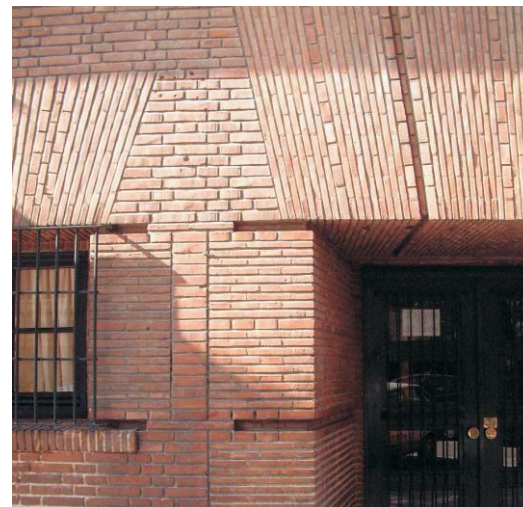
Detalle Portal de Gaztambide 21. MMN Arquitectos. Nov. 2003.
