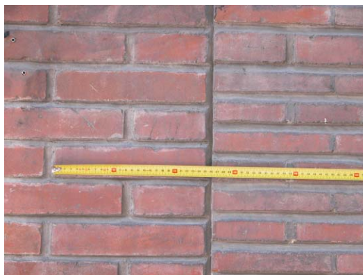
Detalle encuentro de aparejo tipo con jambearo en Portal de Gaztambide 17. MMN Arquitectos. Nov. 2003.
