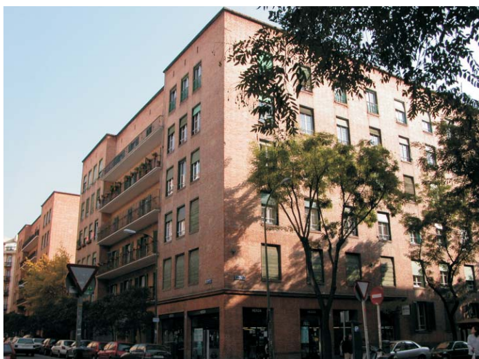
Esquina de Meléndez Valdés con Hilarion Eslava. MMN Arquitectos. Nov-2003.
