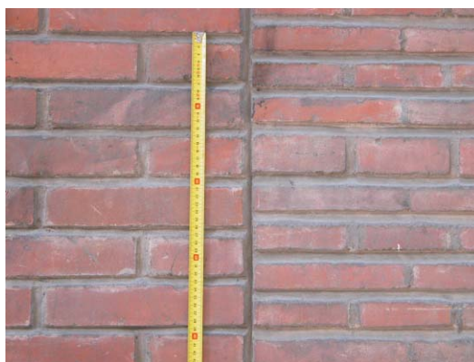
Detalle encuentro de aparejo tipo con jambearo en Portal de Gaztambide 17. MMN Arquitectos. Nov. 2003.
