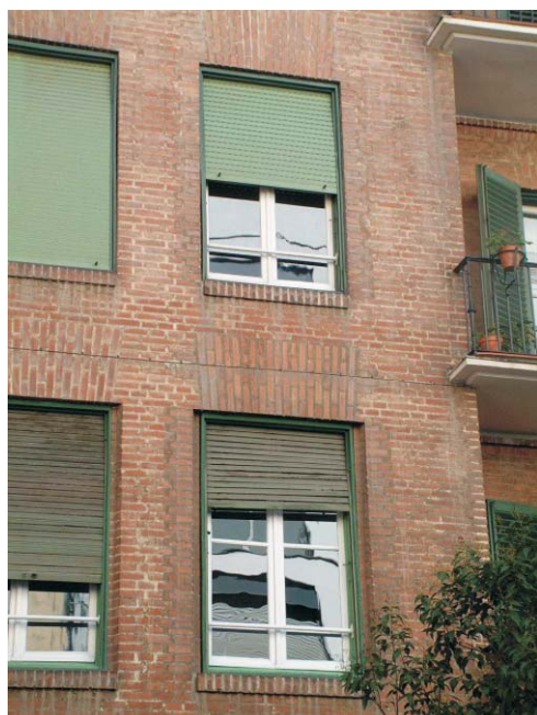
Primer y Segundo piso en Meléndez Valdés 61. Obsérvese el recercado de ladrillo de la ventana de planta baja. MMN Arquitectos, Oct. 2003
