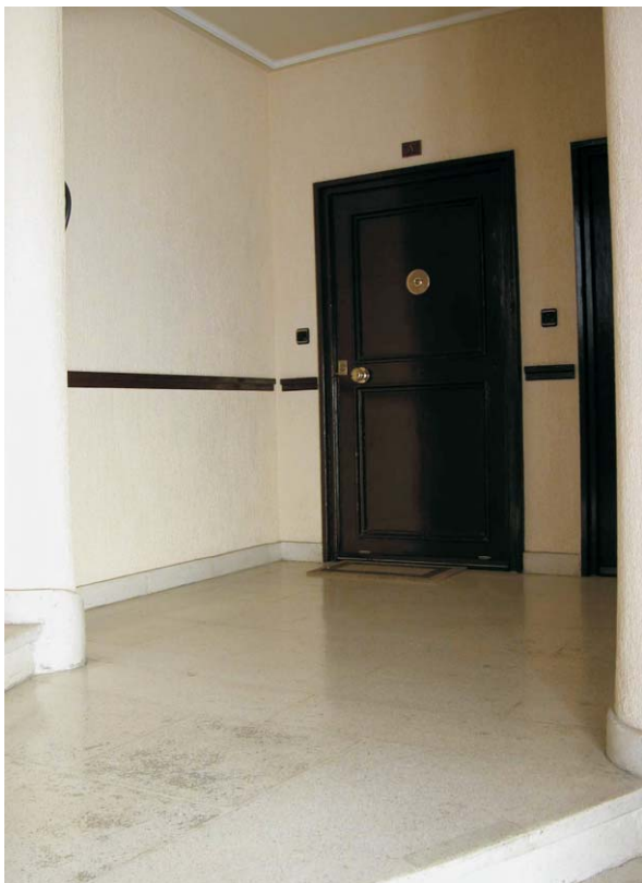
Distribuidor en Gaztambide 21. MMN Arquitectos, Oct. 2003
