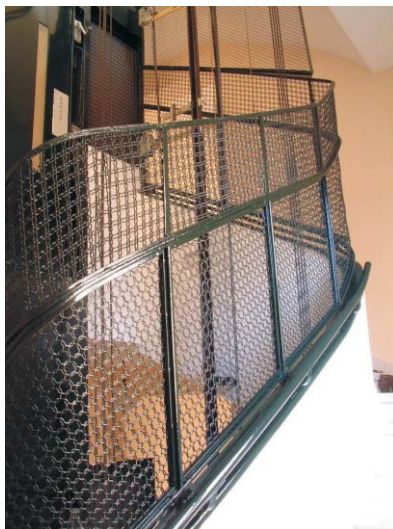
Meléndez Valdés 59. Fotografías: MMN Arquitectos, Oct. 2003
