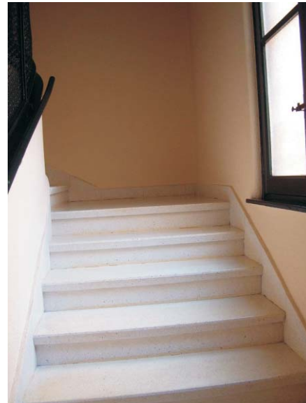
Meléndez Valdés 61. MMN Arquitectos, Oct. 2003
