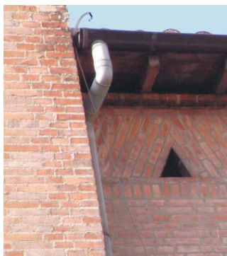
Detalle de bajante de pluviales en calle Gaztambide 19
