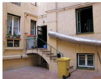
Escalera de acceso a patio en Gaztambide 21
