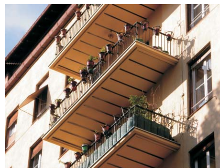
La estructura metálica asomando al exterior (terrazas de Hilarion Eslava, 2). MMN Arquitectos, Oct-2003
