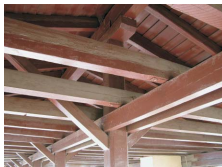
Estructura de madera en cubierta tendaderos. (Hilarion Eslava, 2). MMN Arquitectos, Oct-2003
