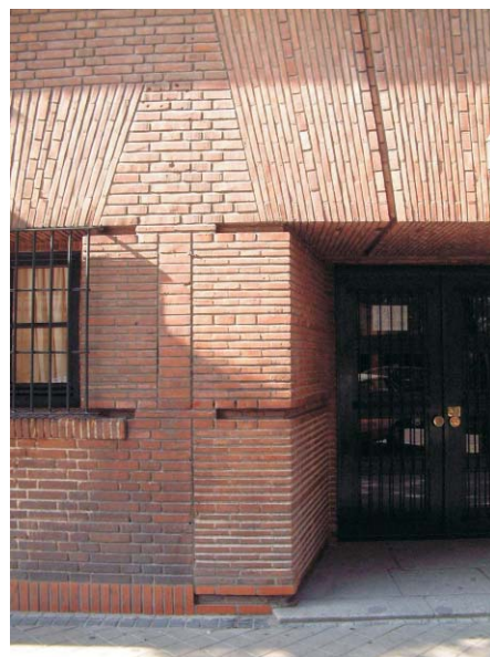
El muro de ladrillo va adaptándose a los huecos con distintos aparejos (Gaztambide 21). MMN Arquitectos, Nov-2003
