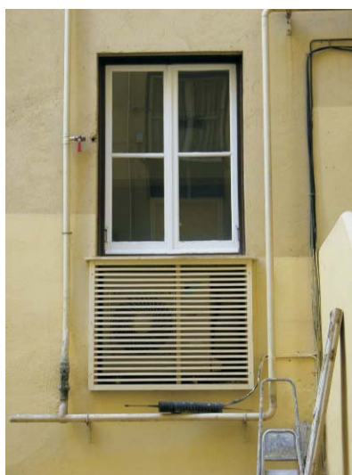
Se eliminan las proporciones del hueco de fresquera y sobresale hacia fachada. Fotografías: MMN Arquitectos, Oct. 2003
