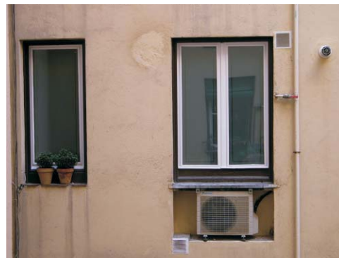
Se eliminan las proporciones del hueco de fresquera y sobresale hacia fachada. Fotografías: MMN Arquitectos, Oct. 2003
