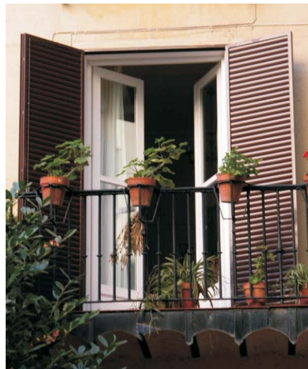
Gaztambide, 17 a Jardín. Fotografía: MMN Arquitectos, Oct. 2003
