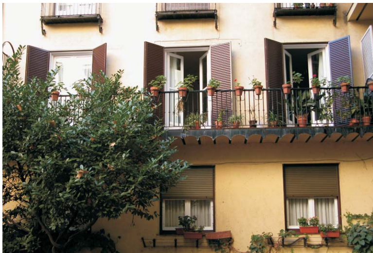
Gaztambide, 17 a Jardín. Fotografía: MMN Arquitectos, Oct. 2003
