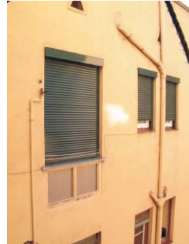
Aparición de tambores al exterior en ventanas que no cuentan con persiana e incluso en otras que sí tienen un capialzado al interior. (MV-59). Fotos MMN arquitectos Oct 2003
