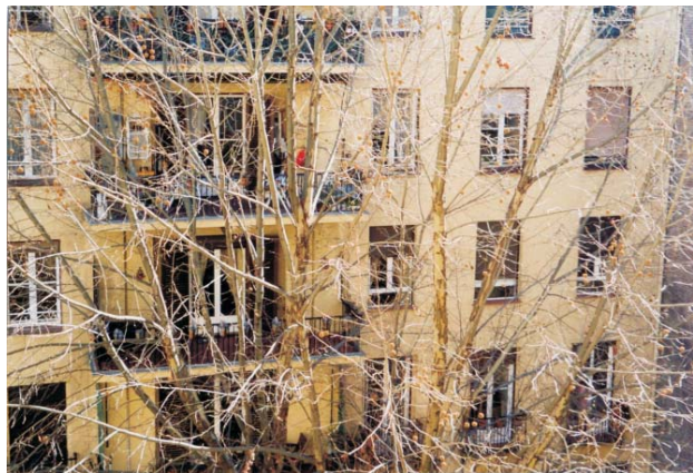
Ventanas y persianas sustituidas por aluminio en fachada incluso reconfiguración de la carpintería, en Gaztambide 17.
