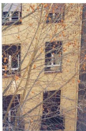
Ventanas y persianas sustituidas por aluminio en fachada incluso reconfiguración de la carpintería, en Gaztambide 17.
