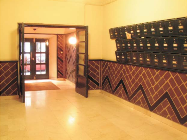
Portal de Meléndez Valdés 59. MMN Arquitectos, Oct. 2003. Suelo de piedra. A la derecha, detalle del encuentro rodapié- zanquín en curva. Se aprecia lo distinto que resultan los rodapié-zanquines, de una pieza curva en el original (abajo) del facetado de la solución en piedra.
