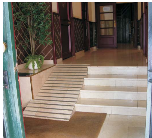
Solado de piedra en Gaztambide 19 y rampa de obra. MMN Arquitectos, Oct. 2003
