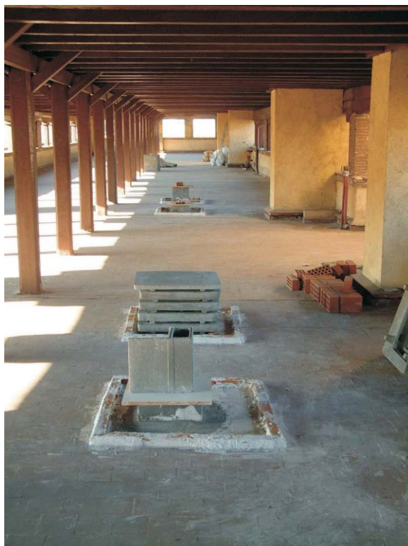
Foto 1º - Chimeneas de nueva construcción en zonas comunes de tendedero en cubierta. Fotografía: MMN Arquitectos. Octubre 2003.
