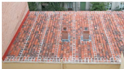
Alteraciones en las viviendas que no contemplan la estructura funcional del edificio en el que se sitúan han provocado la aparición de chimeneas de nueva construcción. Estos elementos además de introducir variaciones de aspecto también introducen nuevos puntos conflictivos constructivamente. Fotografía: MMN Arquitectos. Octubre 2003.
