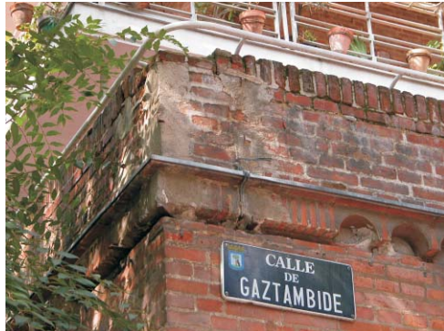
Rodríguez San Pedro, 70. MMN Arquitectos, Oct. 2003
