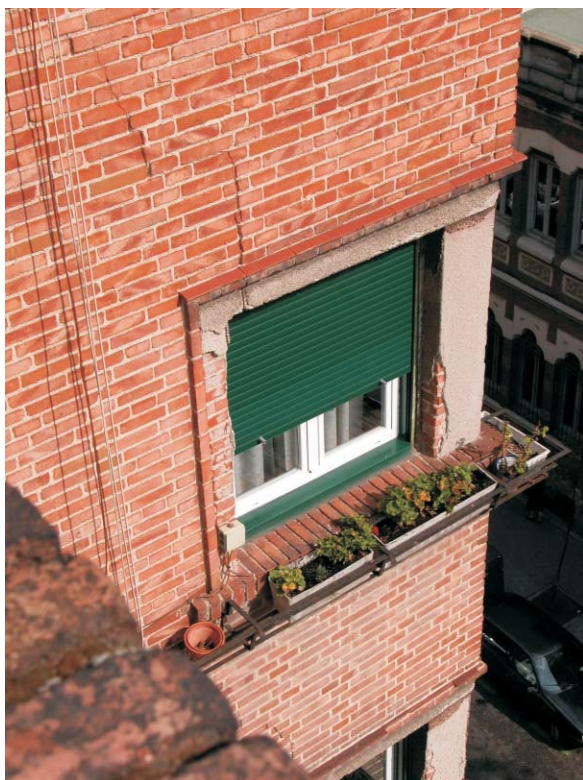
Grieta vertical en la fachada de RP-70 con Gaztambide. La grieta llega hasta la zona inferior de la fachada. Fotografías: MMN Arquitectos. Octubre 2003.
