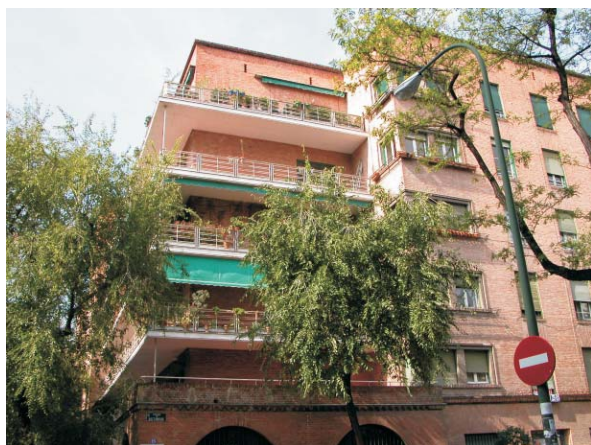
Visión general de la esquina en la que se localiza la grieta. Fotografías: MMN Arquitectos. Octubre 2003.
